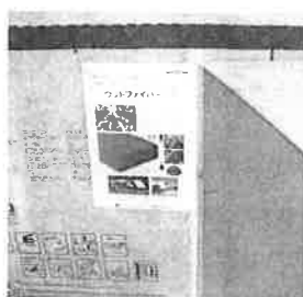
写真4：ウッドファイバーの室内側に、冬は防湿層となるが、夏は外から内に透湿する調湿気密シートを張っている
