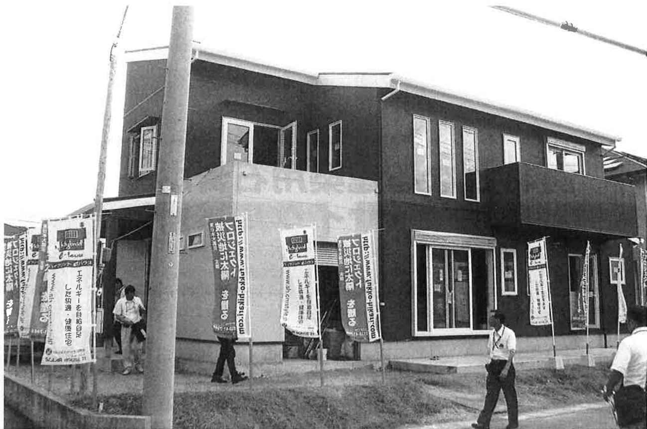
写真1：ソーラーハウス21が建設中のハイブリッドeハウス
